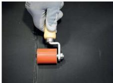
Attendere 10 minuti, quindi passare ancora il rullino, applicando una pressione moderata. Attendere 48 ore prima di poter mettere in tensione il dettaglio. Pulire tutte le macchie di sigillante.
