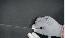
Segnare membrana inferiore lungo la linea di sormonto con un marker bianco.
