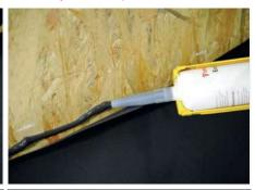
Applicare una linea continua di sigillante tra la membrana e la parete ad 1 cm dalla terminazione del risvolto, ad una velocità di  $\pm$  6s/10 cm (cordolo largo min. 5 mm). Chiudere con il tappo dopo ogni applicazione.
