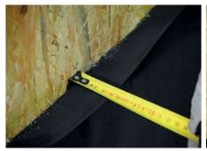
Incollare la membrana PondEasy EPDM mediante l'apposito adesivo Firestone Lining Bonding Adhesive BA-2017 (visitate il sito www.firestonebpe.com per le istruzioni di installazione). Lasciare almeno 5 cm di membrana senza colla.
